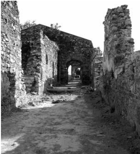
Rami Kütüphanesi'nin restorasyondan önceki hâli.
